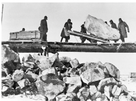
Source 21 : Photographie du chantier du canal Staline (BBK)
